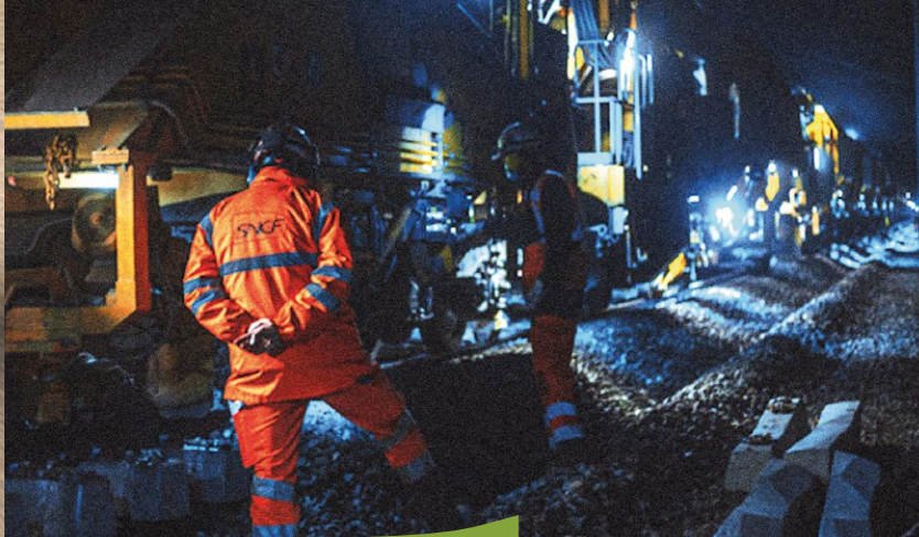
Un chantier imposant, exigeant et mouvant
